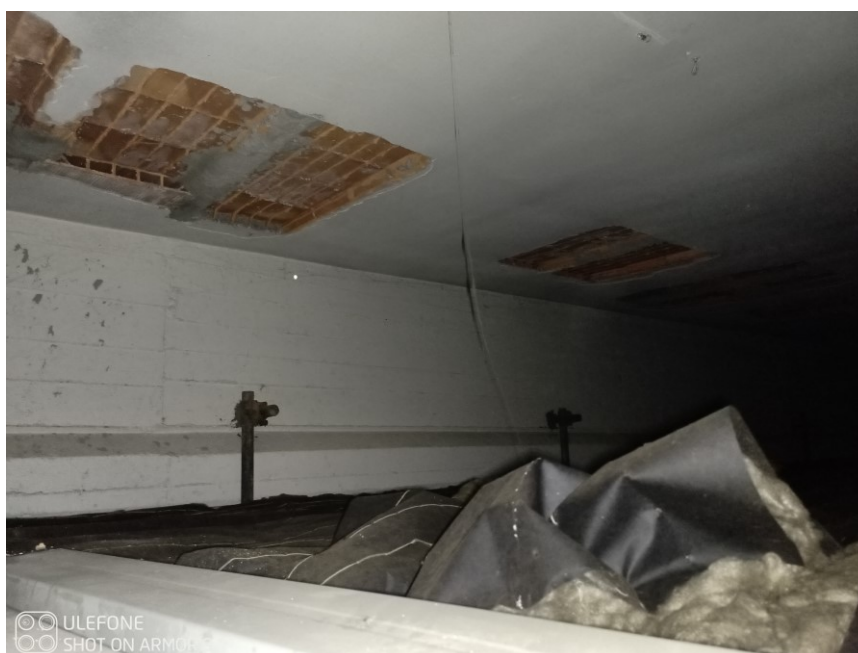
TRAVE DI COPERTURA PALESTRA RILEVATA A SEGUITO DI INDAGINE
