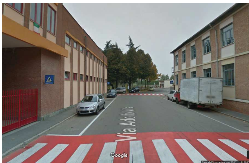
Figura 3 – AFFACCIO OVEST: a destra è visibile l'edificio scolastico oggetto di diagnosi, mentre a sinistra è visibile la sede della scuola media, di altezza confrontabile
